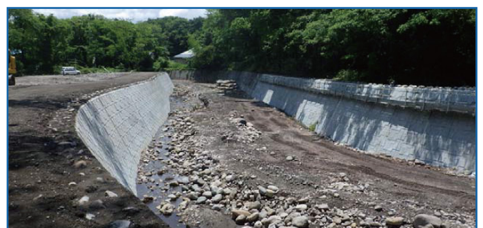
災害復旧工事
