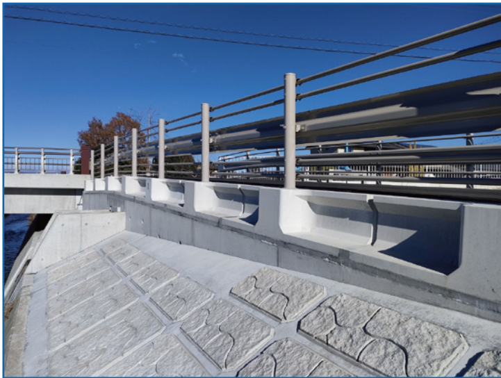
L型擁壁天端上部
