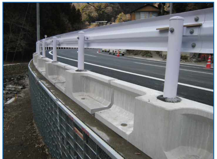
鋼製擁壁上部
