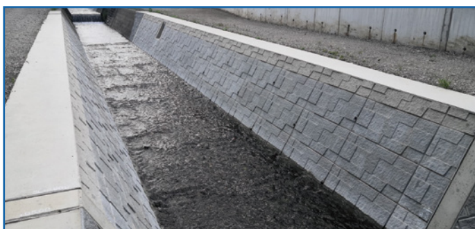
災害復旧工事
