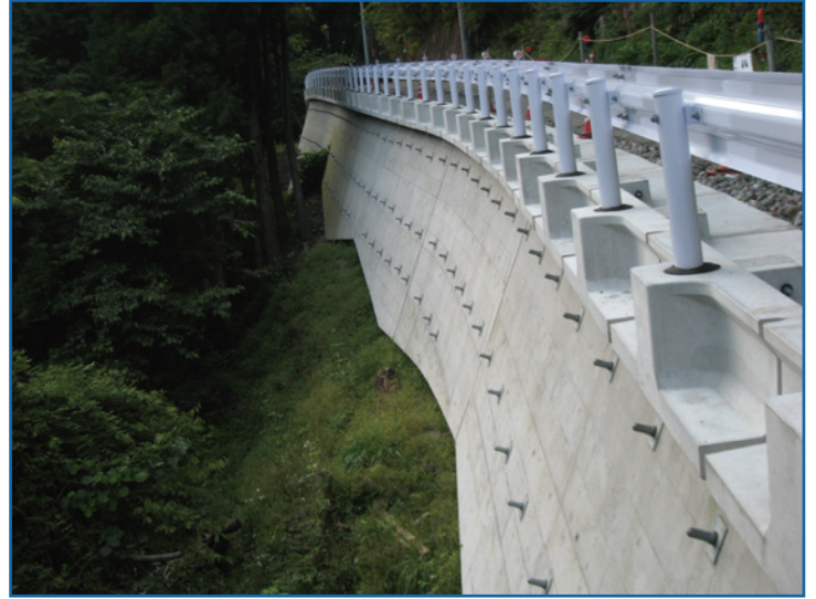
擁壁腹付け工上部張り出し
