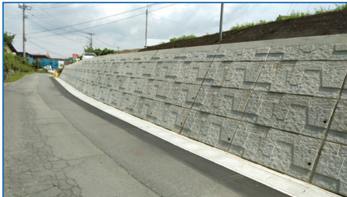
道路改良工事
