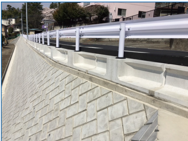
間知ブロック上部
