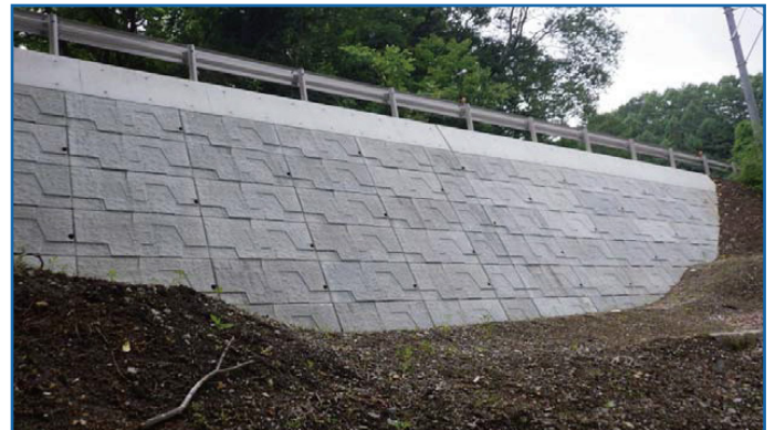
道路拡幅工事
