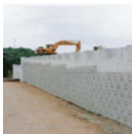
補強土壁（ジオグリッド）
