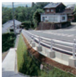
補強土壁 （ジオテキスタイル）
