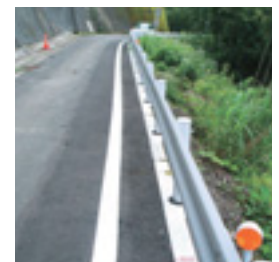
拡幅工事に単独使用
