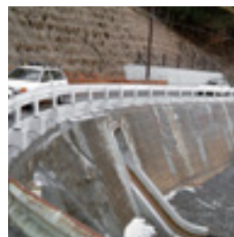
既設ブロック
