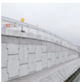
補強土壁（テールアルメ）
