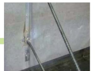
地面と接する最下段は、地面とアングル間は鉄筋かぶり確保する
