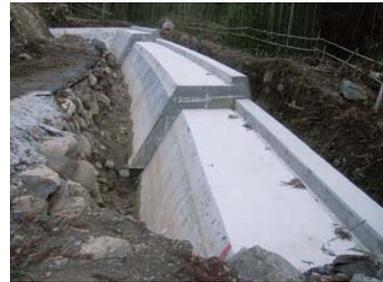
補強土壁の基礎が完成した状況
