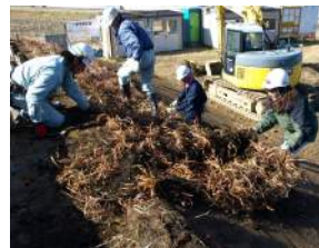
チガヤマットの設置状況
