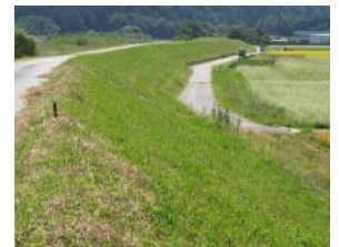
設置から1年が経過した 堤防法面の状況
