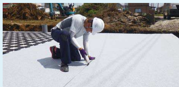
透水シートの敷設後全景
