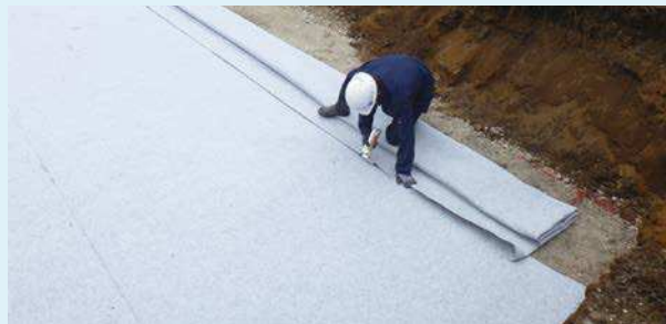
貯留構造体の組立①（本体）
