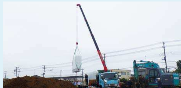
貯留構造体の組立②（フレーム）
