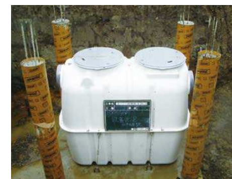
沈砂槽
