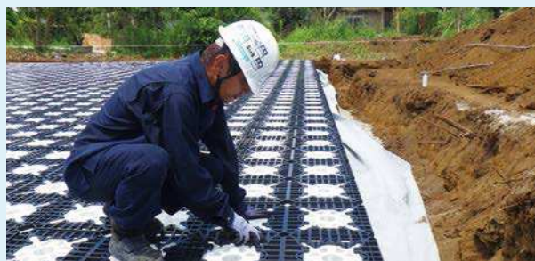
透水シートの敷設（側面）
