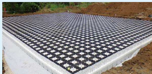
透水シートの敷設（上面）
