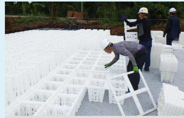
施行中の様子
