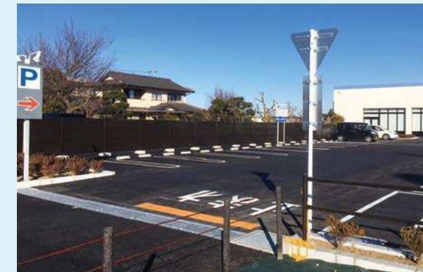
舗装後の状況
