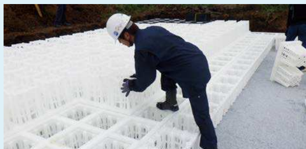
貯留構造体の組立③（天板）
