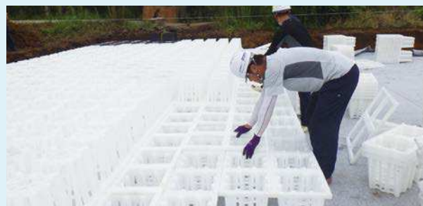
貯留構造体組立後全景
