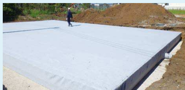
透水シートの敷設後全景
