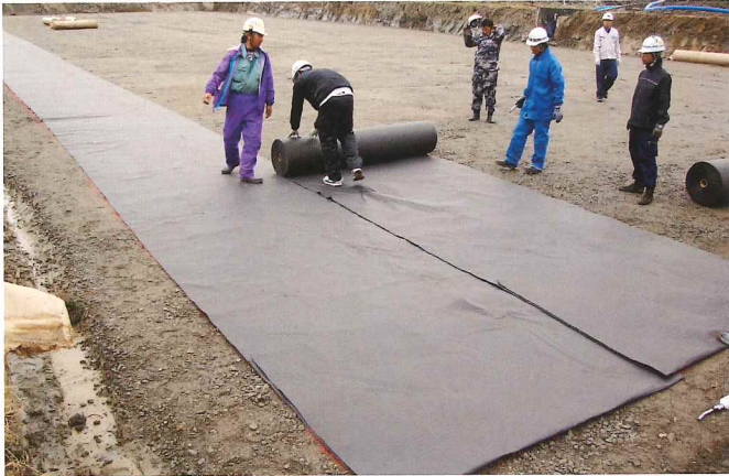
① 底面保護シート敷設
