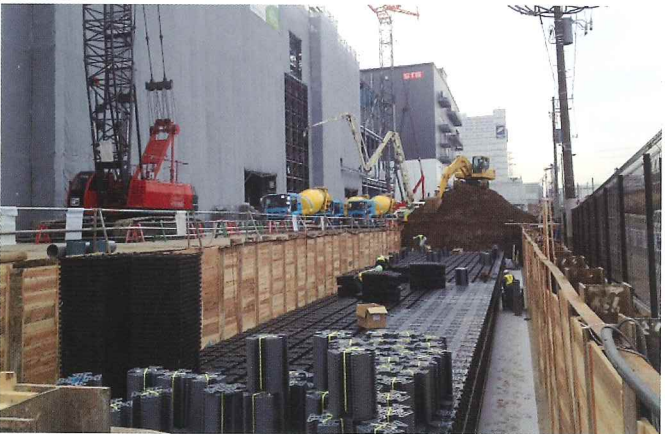
工場（駐車場に設置）
