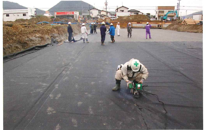
② 底面遮水シート溶着
