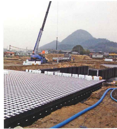
④ トッププレート設置
