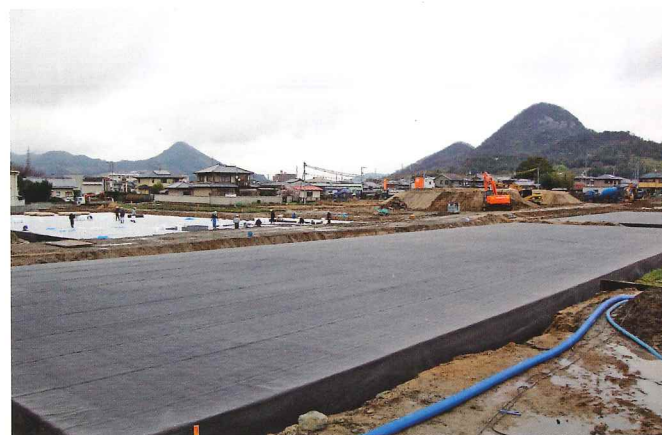
⑦ 上部シート敷設完了
