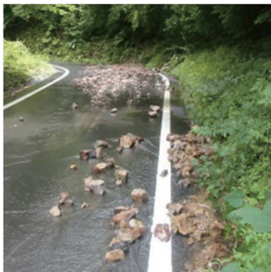
小規模落石の状況
