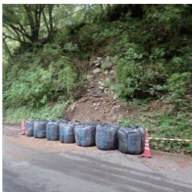
大型土のう対処事例
