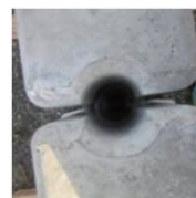
設置後に上から見た状態
