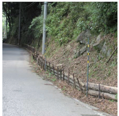
簡易木柵による対処事例
