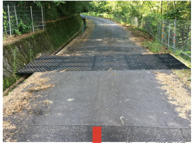
グレーチング設置状況
