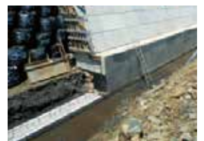
5段目までの施工状況
