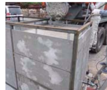
コンクリートの打設状況
