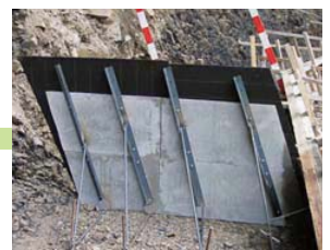
目地材を貼り付けて完了
