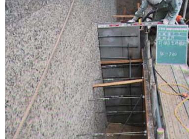
谷止工（嵩上げ）
