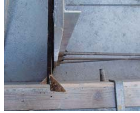
目地端部固定状況
