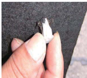
先端を閉じ目地材側から押し込みます
