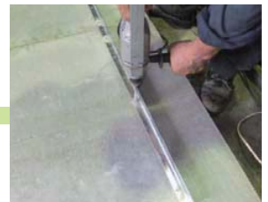
平地で縦バタ用鋼材の位置決めし、スレートボードに削孔(平地で組み立てた場合)
