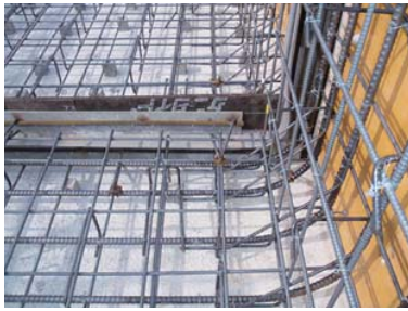
U型擁壁 (隅角部)
