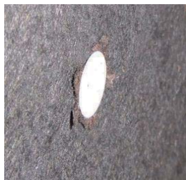
目地材側の設置した状況
