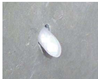
スレートボード側に押し込んだ状況
