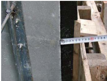
スレートボードを型枠から 50mm 引いた位置に設置した状況
