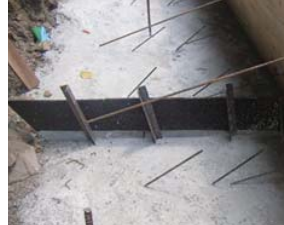
一段目の打設が完了
