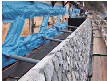
化粧型枠の内側に目地材を設置した状況
