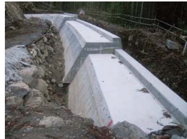
補強土壁の基礎が完成した状況
