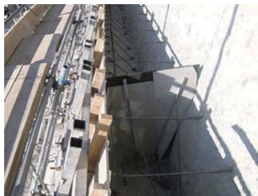
張コンクリート擁壁 その2
