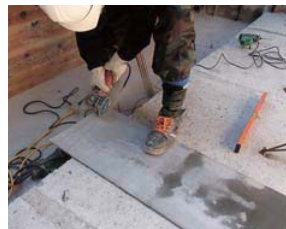
位置寸法に合わせて切断
