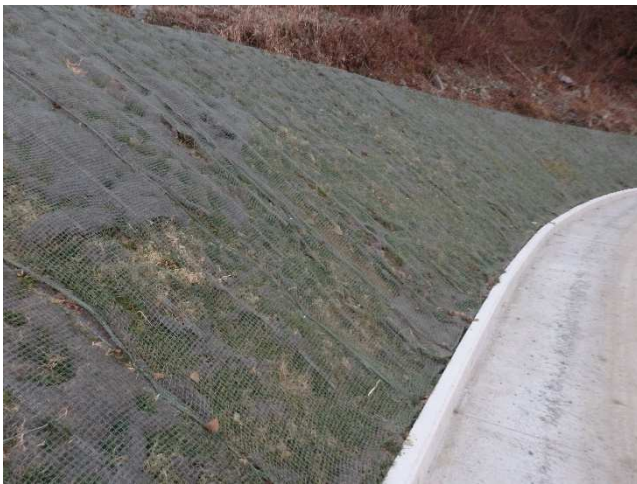
植生基材マット工 亀甲金網なし/食害+踏み荒らし
