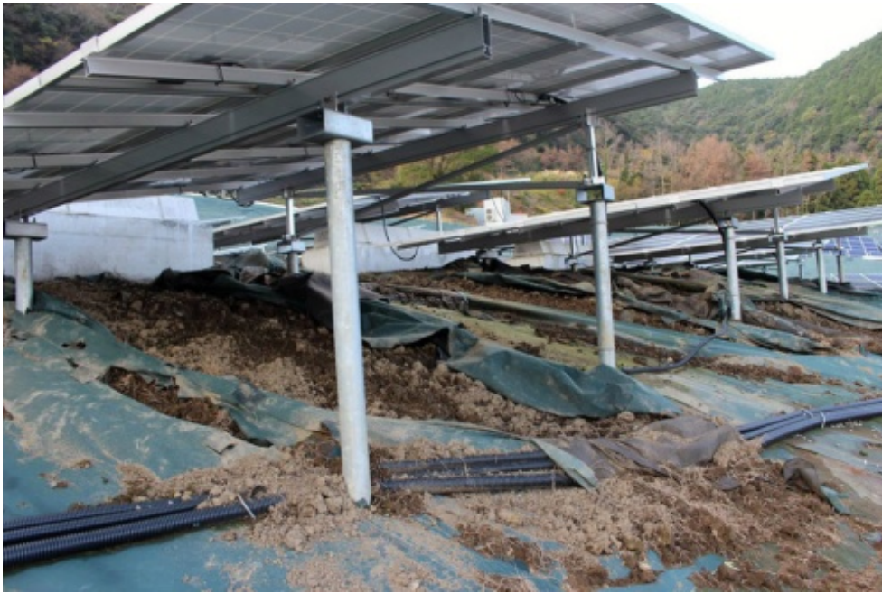
図1●フェンス際を掘り込まれたり、防草シートが破られたりする (出所:日経BP)
