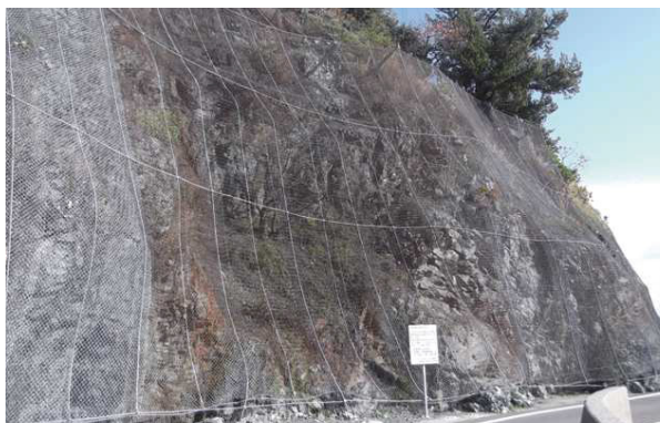
平成 26 年 4 月 佐賀関循環線災害防除工事（大分県）
