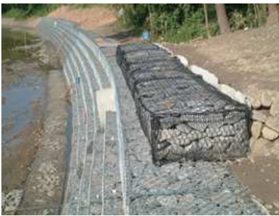
平成 15 年 11 月 大淀川支流河川洗堀防止工事(宮崎県)
