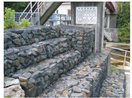
平成 18 年 11 月 立谷沢川第二発電所用水路側溝集水工耕地 修繕工事(東北電力)
