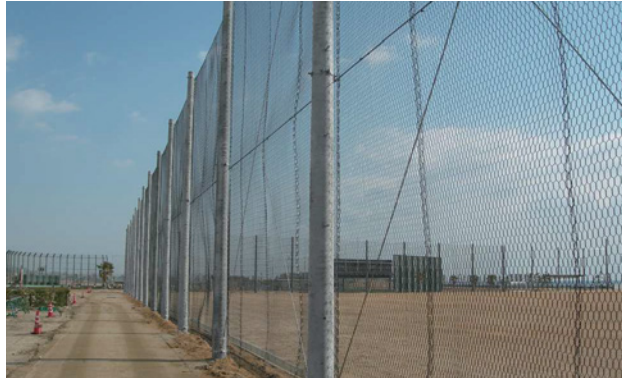
平成 23 年 2 月 佐野運動公園防球ネット整備工事
