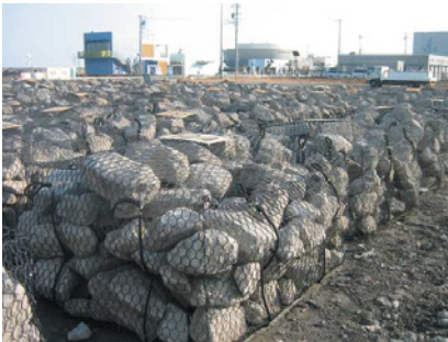
平成 19 年 12 月 焼津漁港海岸保全施設整備工事(静岡県)
