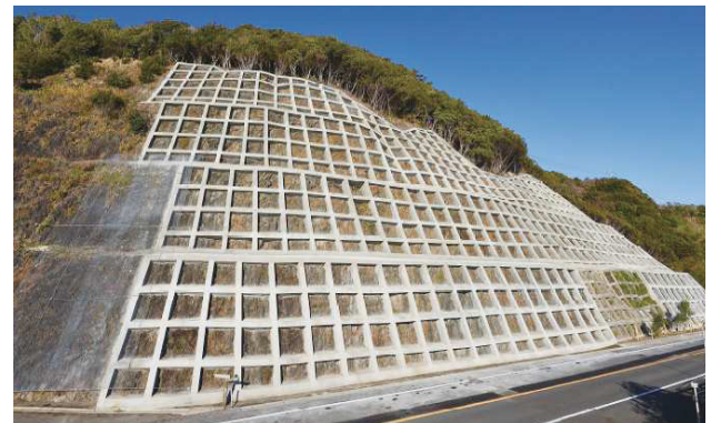
平成 26 年 10 月 国道 321 号防災・安全交付金工事
