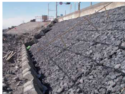
平成 23 年 12 月 静岡海岸 老朽化対策緊急事業工事(静岡県)
