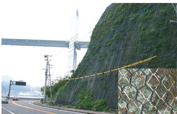
一般国道 499 号道路災害防除工事（長崎県長崎市）
