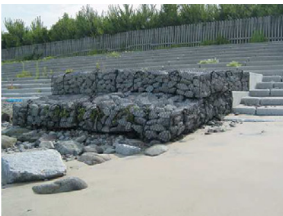
平成 21 年 4 月 国東港向田地区海岸浸食防止(大分県)
