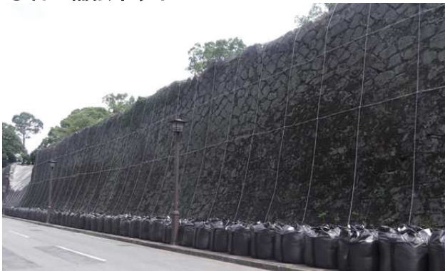
平成 28 年 7 月 熊本地震熊本城百間石垣補修工事
