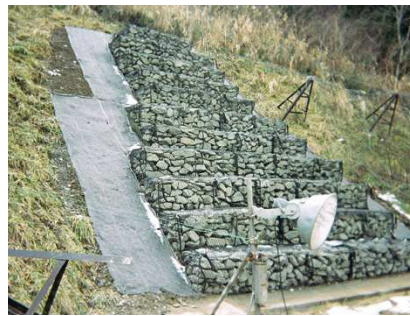
平成 15 年 10 月 一の瀬第一トンネル工事(JH)
