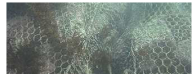
F-REN マット設置後の状況
