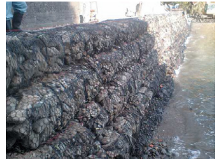
平成 20 年 11 月 丑越護岸 町単独災害復旧工事(静岡県西伊豆町)
