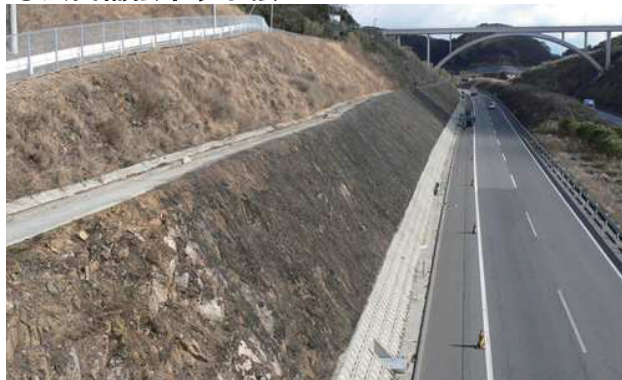
平成 22 年 1 月 神戸管内のり面防災対策工事
