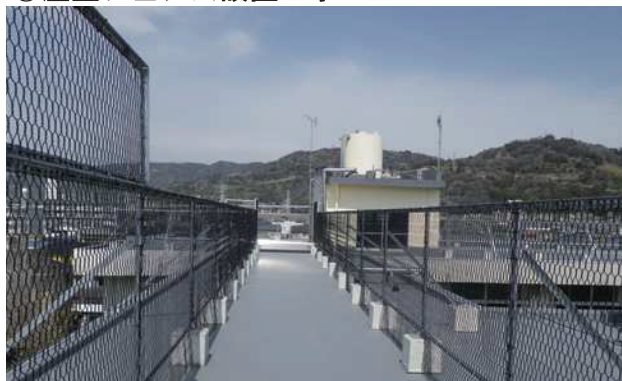
平成 24 年 2 月 小田原市立国府津小学校屋上フェンス設置工事
