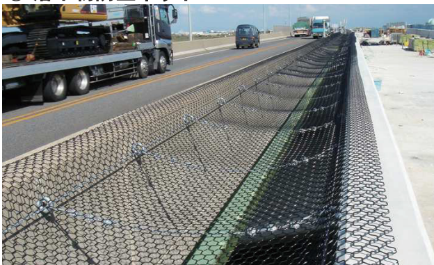
平成 17 年 9 月 国道 116 号線新川橋落下物防止網設置工事
