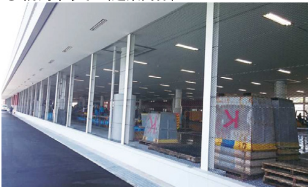
平成 27 年 3 月 唐津港まき網市場改修その他建築工事
