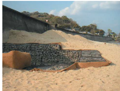
平成 20 年 3 月 一般国道 251 号道路 災害防除工事(長崎県)
