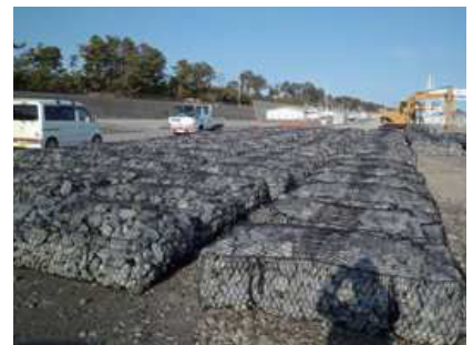
平成 23 年 12 月 水魚単第 1 号用宗漁港 緩傾斜護岸修繕工事(静岡県静岡市)
