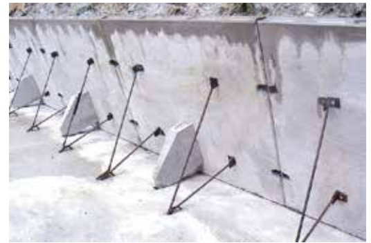
連結金具溶接完了
