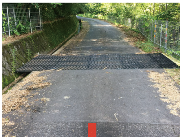
グレーチング設置状況
